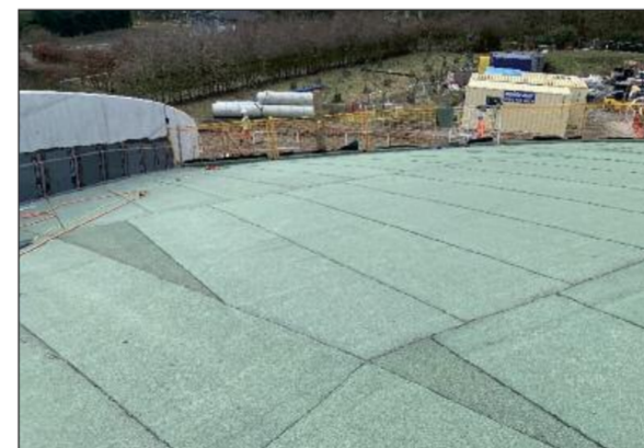
Zweite Abdichtungslage BauderPLANT E mit integriertem Durchwurzelungsschutz.
