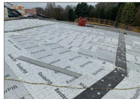
Verlegte Wärmedämmung aus BauderPIR.
