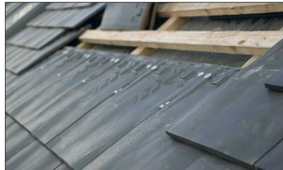
Die Biberschwanzkammer 425-031 von FOS sichert den Edilians Stretto auf der Dachfläche des Bauabschnitts Knightbridge zuverlässig gegen Windstog.
