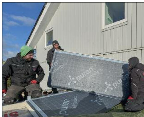
Aufgrund der Dachneigung von nur 9 Grad und der vorgesehenen Nutzung kam auf dem rund 200 Quadratmeter großen Satteldach über dem Anbau das puren Unterdach 023 zum Einsatz. | Foto: puren
